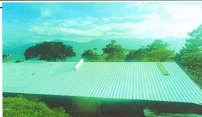
Foto 3: CUBIERTA DE LAMINA
